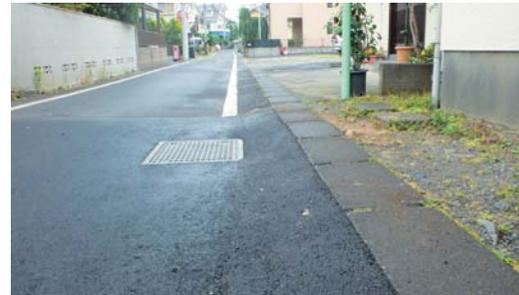
←雨水浸透ますを設置。道路に傾斜もつけ、水はけを良くしました。今後本格的な補修が行われます。
