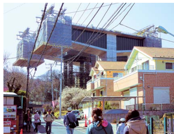
▲裏高尾の圏央道橋脚工事
