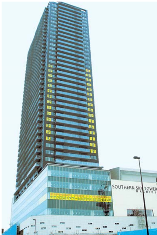
▲建設が進む八王子駅南口再開発ビル
