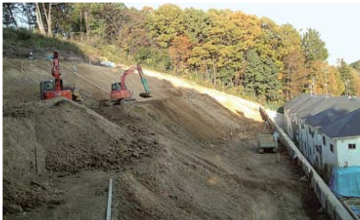
復旧工事が進む川町の土砂流出現場 (08年11月)
