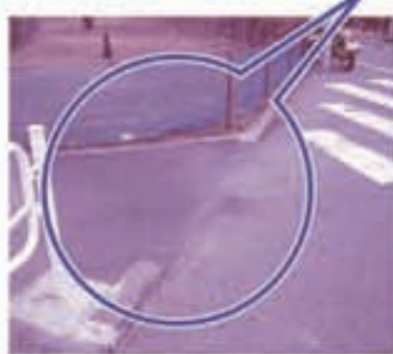
段差解消した歩道
